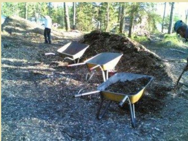
Kottikärryt odottavat täyttämistä
